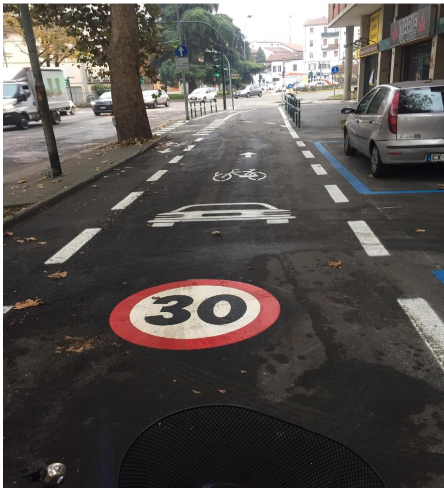
Esempio di applicazione integrata di alcuni dei nuovi dispositivi: strada urbana ciclabile con doppio senso ciclabile (Reggio Emilia)
