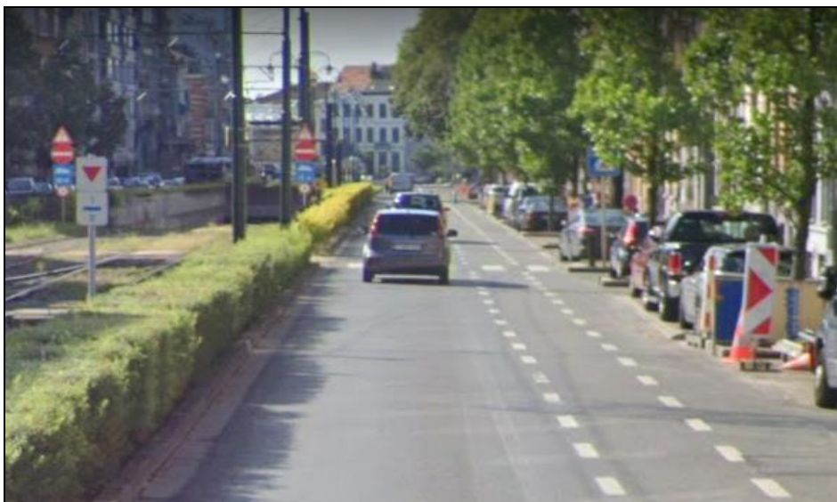
Il franco rispetto alla sosta è ampliato riducendo l'ampiezza della corsia ciclabile (Bruxelles).
