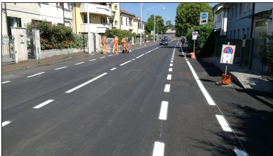
Tracciamento di una corsia ciclabile (Padova)
