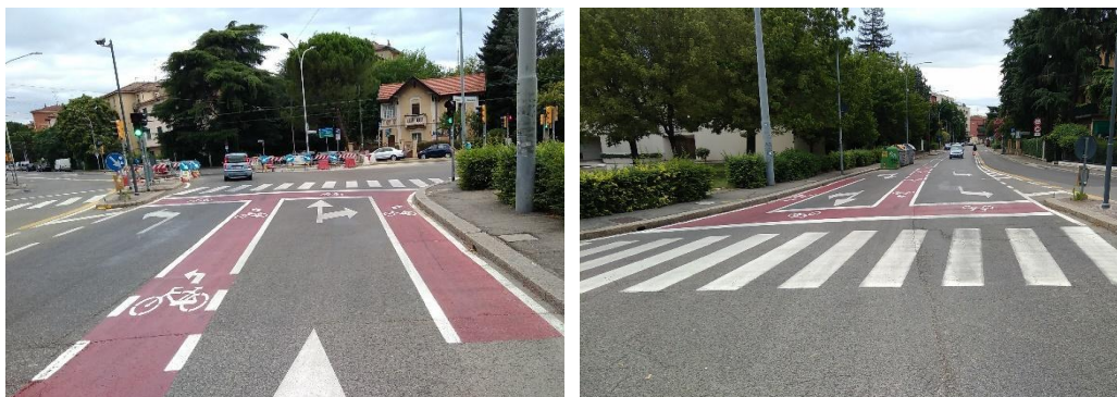
Casa avanzata con corsia di accesso sul lato destro della corsia specializzata centrale -Bologna, via Saragozza
